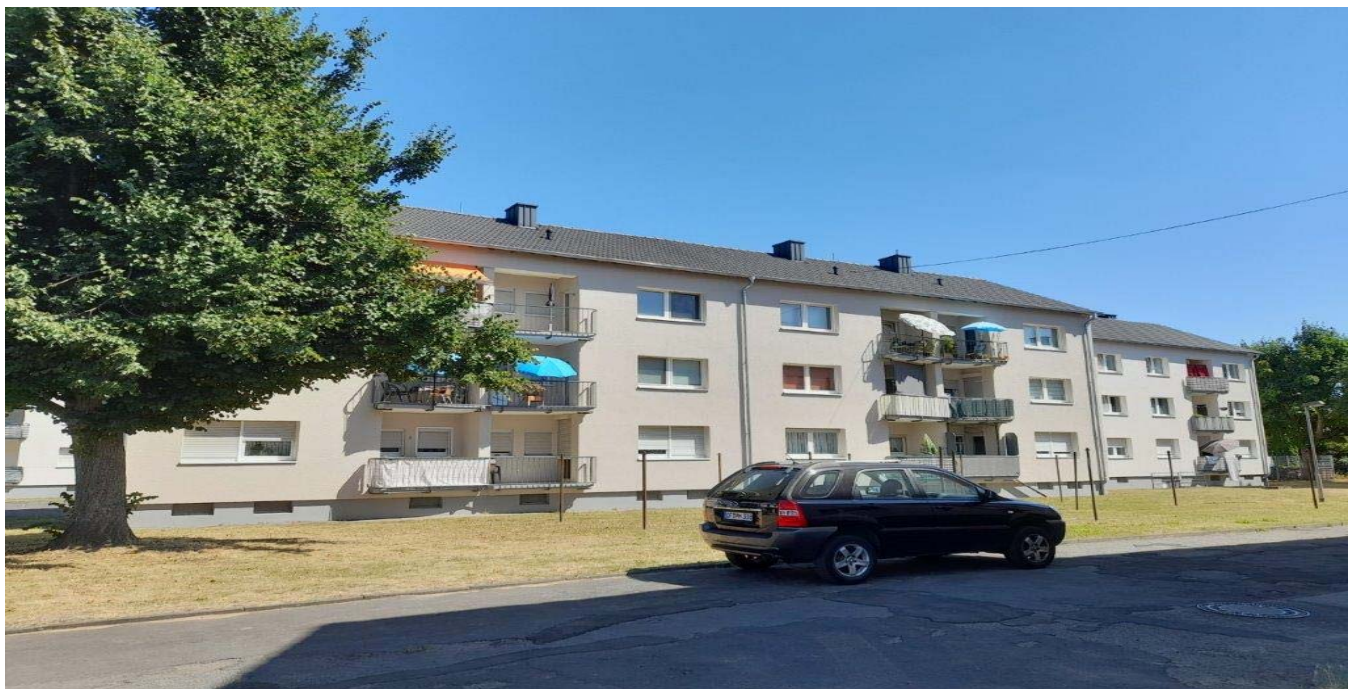
Wohnhäuser Querstr. 41-51, 63500 Seligenstadt
