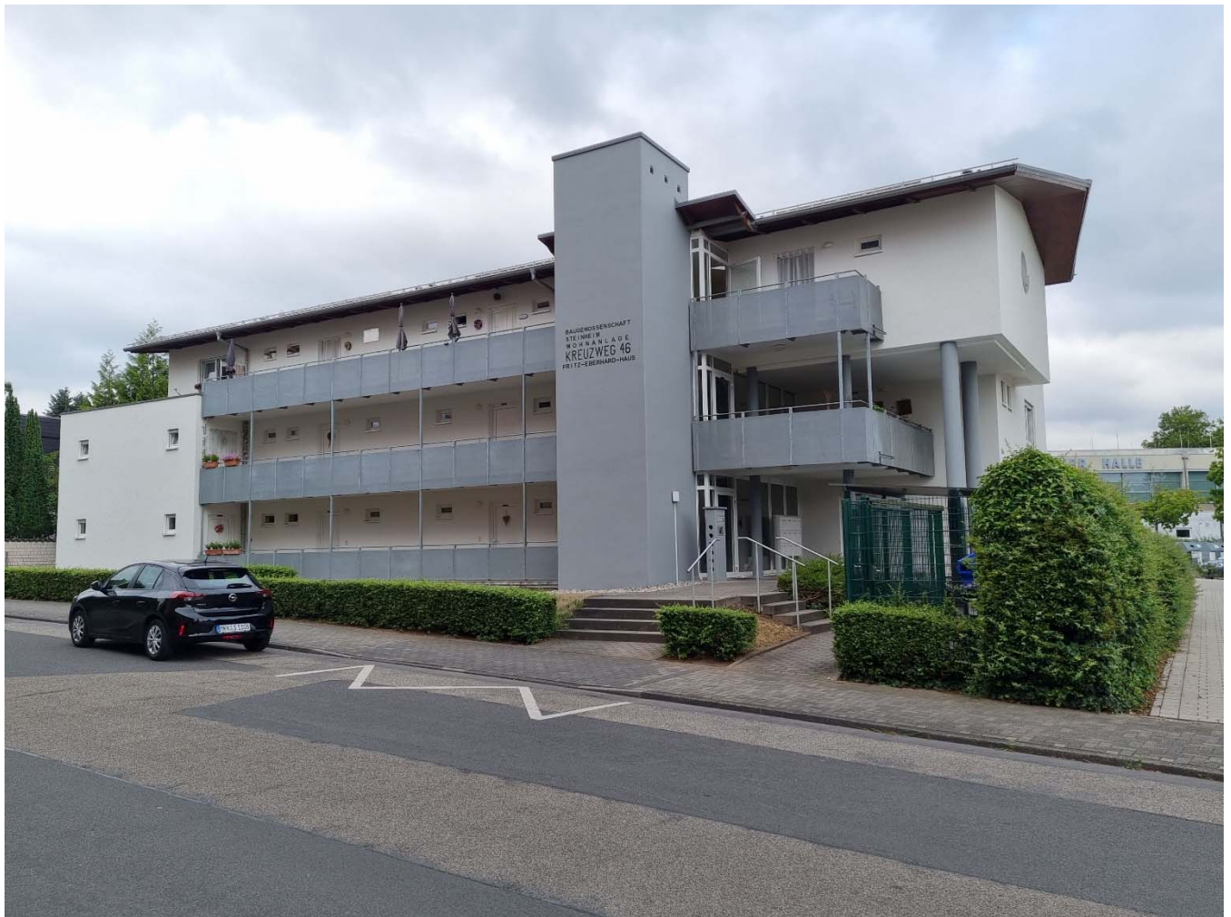
Das Objekt Kreuzweg 46, Hanau-Steinheim mit neuer Fassade
